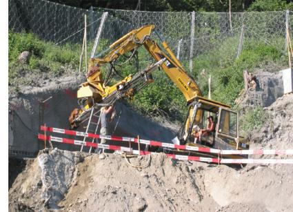
As pregagens RC são principalmente utilizadas para a estabilização de taludes rochosos, quando é necessário consolidar substratos rochosos e ao mesmo tempo, servir de apoio aos revestimentos superficiais realizados com redes e painéis. São produzidas em aço de várias resistências e possuem um rosca contínua que permite uma melhor aderência à calda de cimento, bem como a possibilidade de enroscar a porca mesmo em caso de corte do varão. Podem ser fornecidas em vários comprimentos e galvanizadas.
